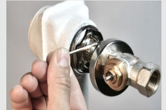
Mit Inbusschlüssel obere Schraube leicht lösen. Nicht herausrauben. Auf Wasseraustritt achten.
